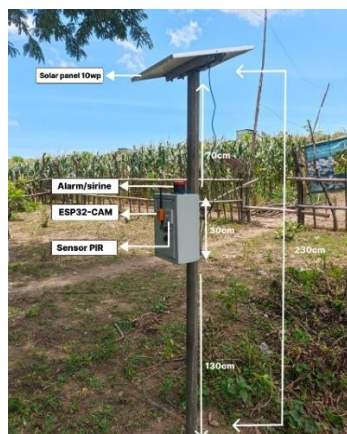
Gambar 6. Implementasi Sistem di Area Pertanian Pengujian Sensor PIR
