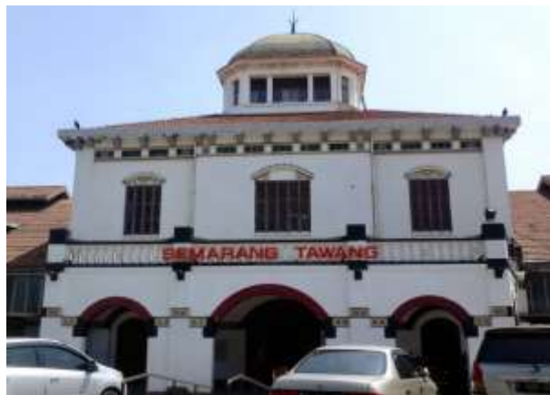
Gambar 5. Kemegahan Arsitektur Stasiun Tawang [Sumber: Dokumentasi Agus Setiawan, 2018]
